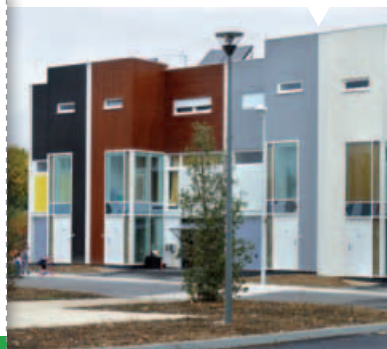
Habitat social à Très Haute Performance Énergétique et Bâtiment BBC
